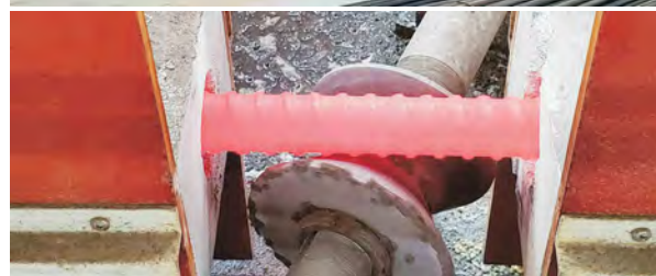
Automatic processing line 全自动钢筋升级线
